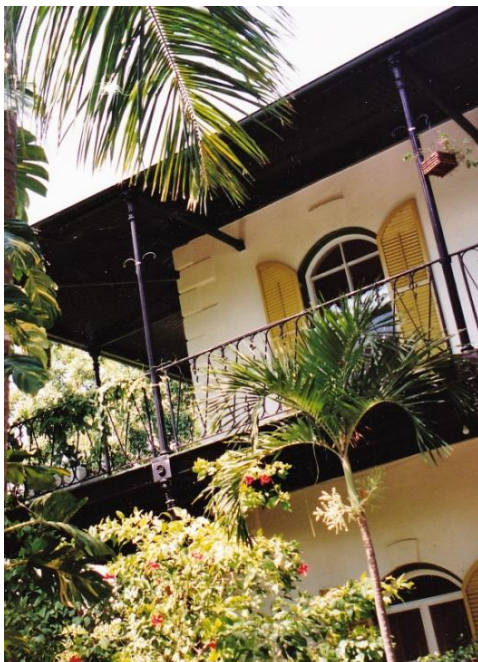
Maison d'Ernest Hemingway à Key West
